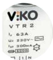
Для обеспечения защиты электропроводки от возгорания используются устройства защитного отключения **300 mA**.
